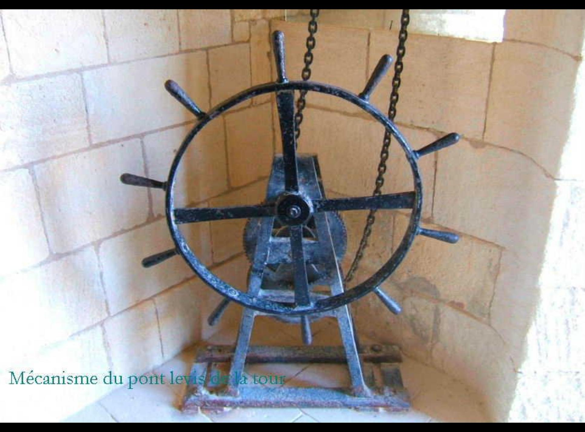
Mécanisme du pont levis de la tour
